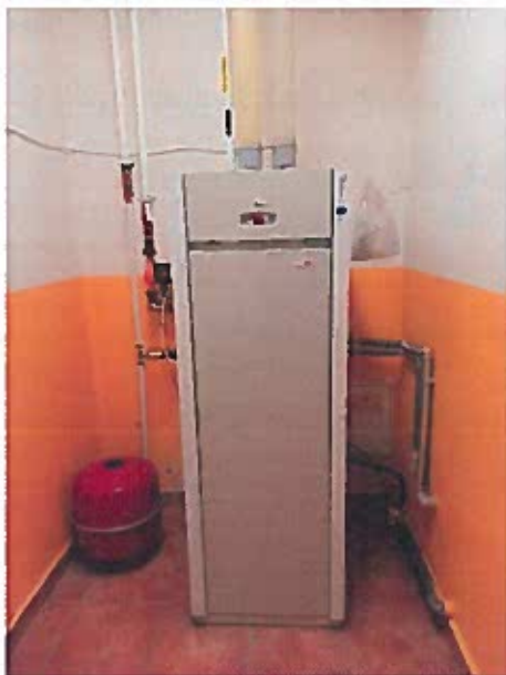
Systém prípravy teplej vody
