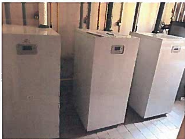
Systém prípravy teplej vody
